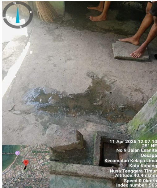
Sumur resapan
