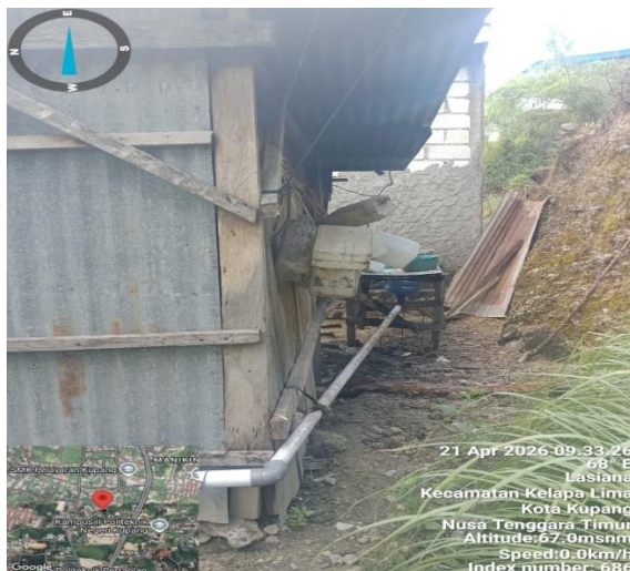
Saluran pembuangan limbah kedap tertutup
