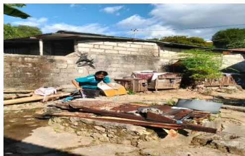
Kondisi sumur yang lantai sumur retak
