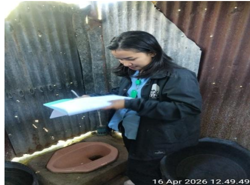
Insepksi kondisi sarana toilet
