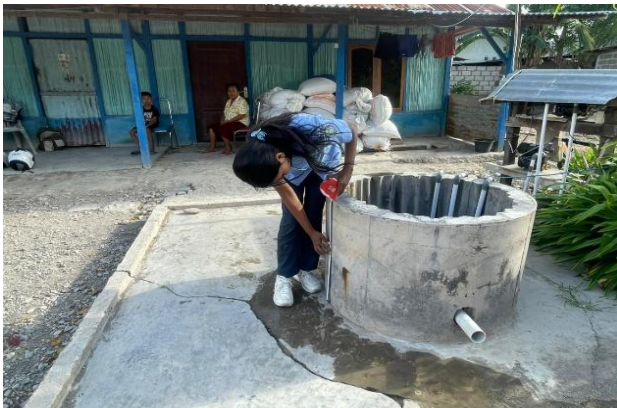
Pengukuran bibir sumur gali menggunakan alat ukur (meter)
