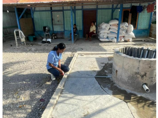
Mengukur lantai sumur gali menggunakan alat ukur (meter)
