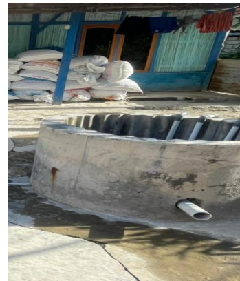
Menilai kondisi fisik sumur gali
