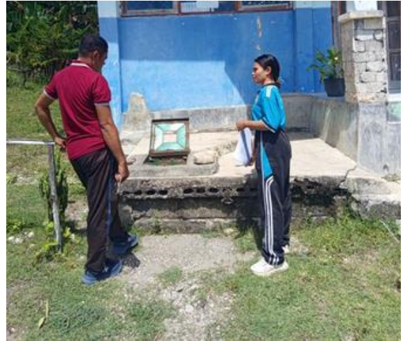
Inspeksi kondisi sarana air bersih
