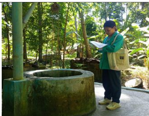
inspeksi sumur gali
