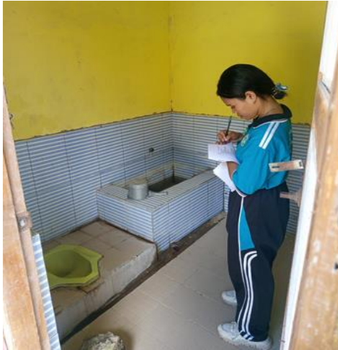
Inspeksi kondisi jamban
