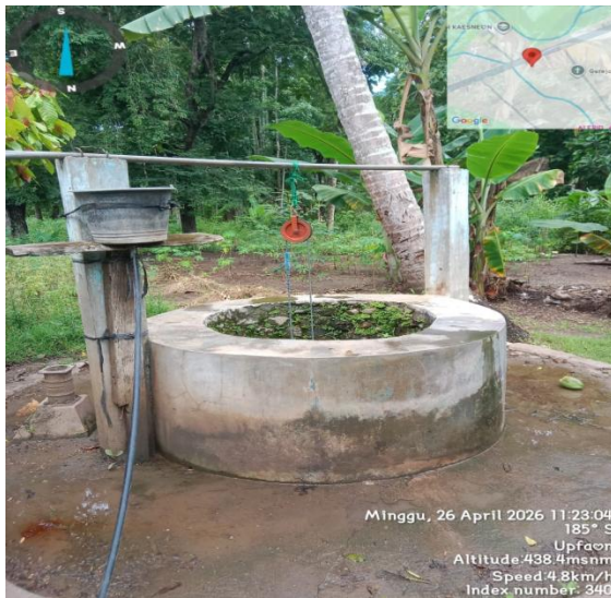
Kondisi Sumur Gali
