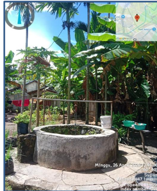
Gambar 2. Kondisi Fisik Sumur Gali
