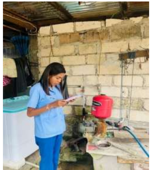
Pemeriksaan kondisi fisik sumur gali pasar Naikoten
