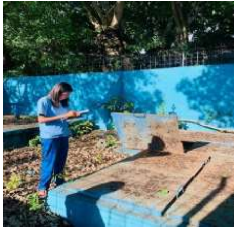
Pemeriksaan Kondisi Fisik Sarana Air Bersih di Pasar Oeba
