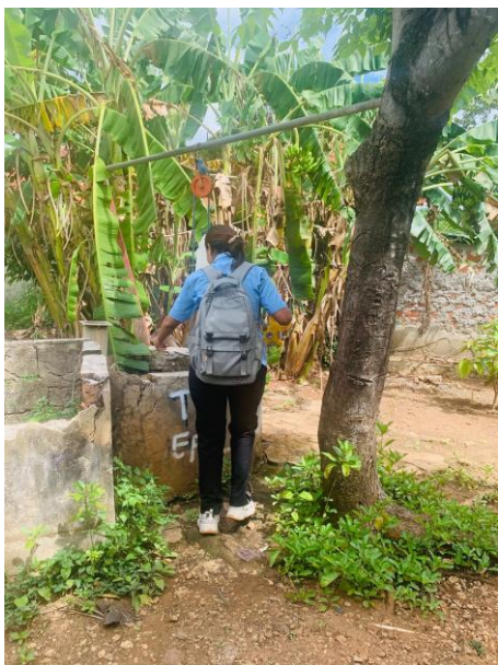
Mengukur dinding sumur
