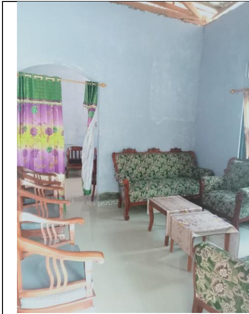
Inspeksi Sarana Pencahayaan, Lantai.
