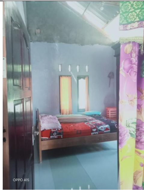
Inspeksi Sarana Ventilasi, Ruang Tidur
