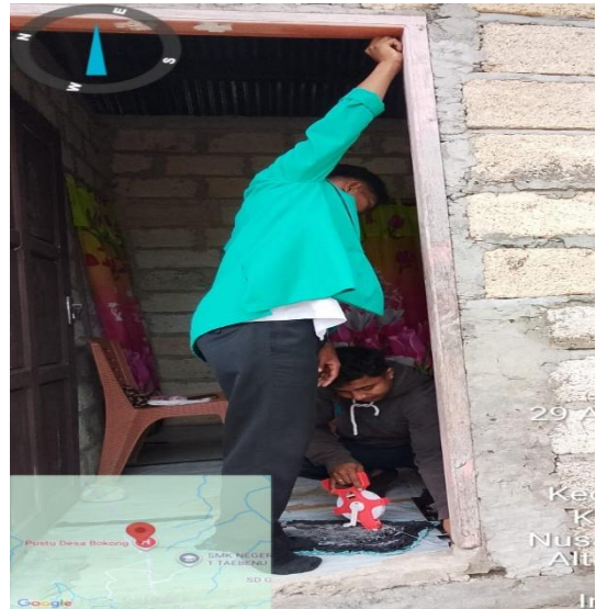
Melakukan pengukuran panjang pintu
