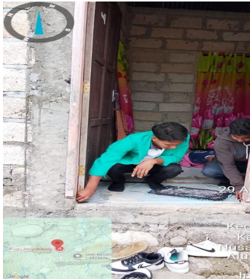
Melakukan pengukuran lebar pintu
