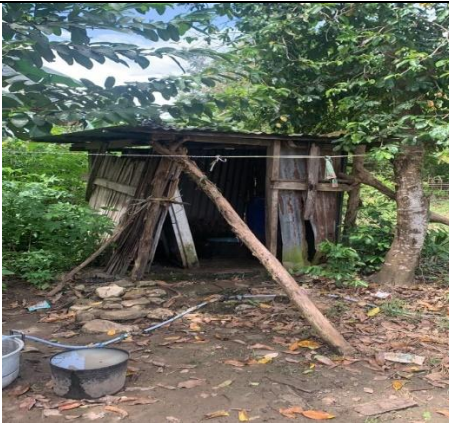
Kondisi bangunan jamban
