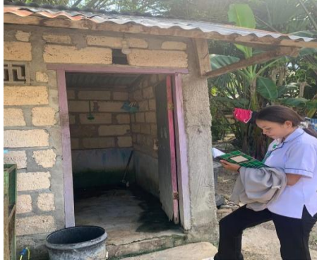
Pemeriksaan kondisi fisik jamban
