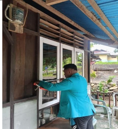
Pengukuran Jendela rumah
