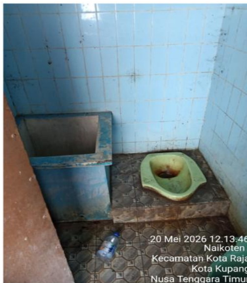
Kondisi Jamban Pasar Fatubesi
