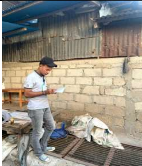
Saluran pembuangan air limbah dan Drainase
