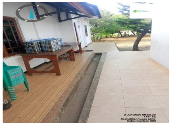
Inspeksi sarana SPAL
