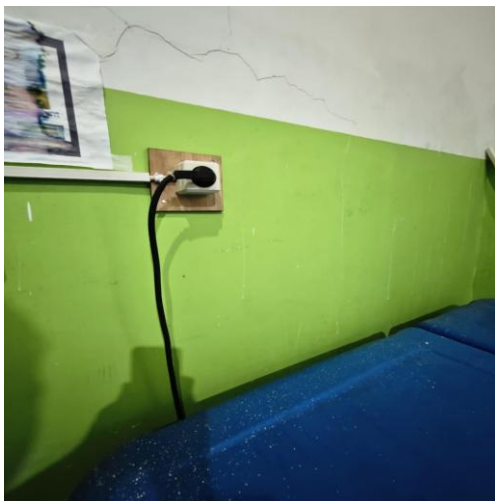
Gambar 3 Satu stop kontak untuk satu lemari vaksin
