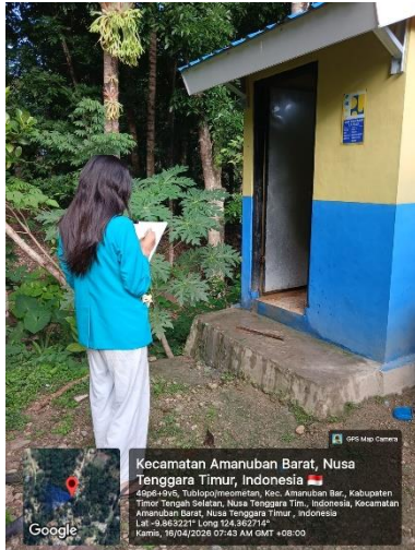
Kondisi jamban yang memenuhi syarat
