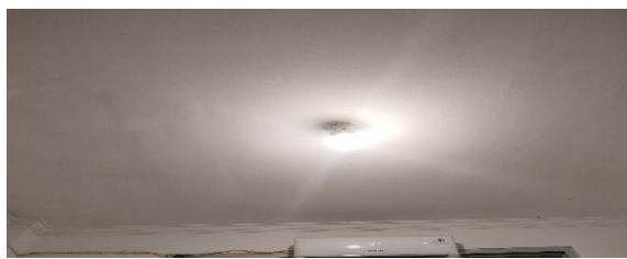
Gambar 15.17 Plafon gudang bebas dari keberadaan hama
