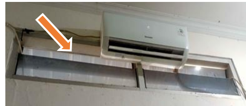
Gambar 16.10 Tersedia ventilasi sehingga aliran udara berjalan dengan baik
