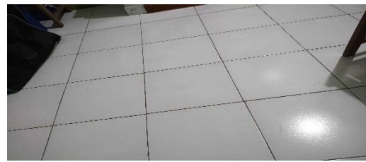
Gambar 16.8 Lantai terbuat dari tegel dan dalam kondisi bersih
