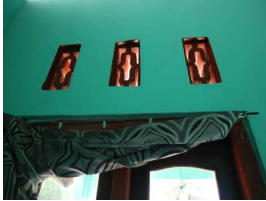
Gambar 9. Ventilasi rumah tanpa kawat kasa
