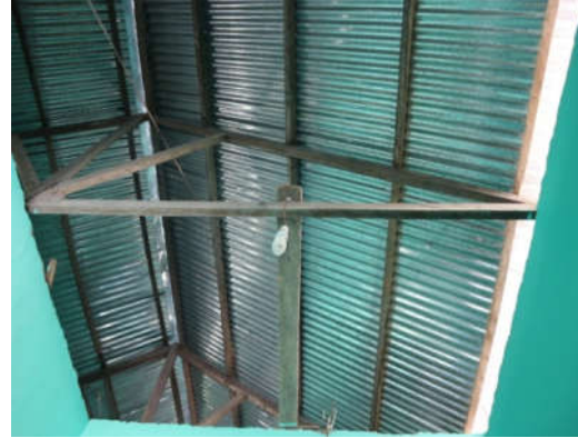
Gambar 10. Rumah tanpa plafon
