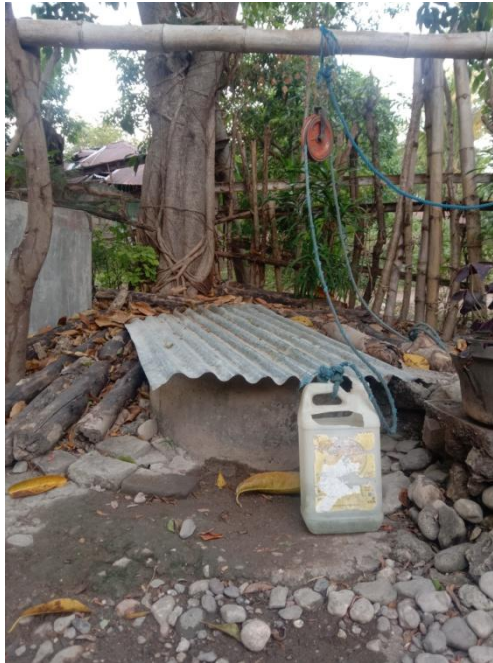
Kondisi Penutup Sumur Gali
