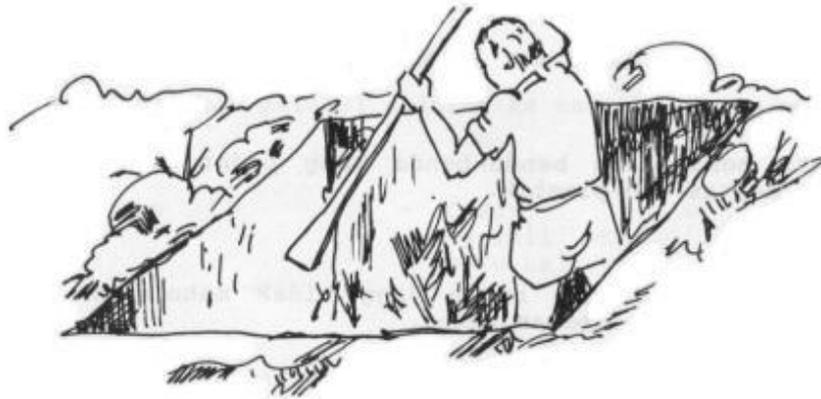
Digali lubang di luar dapur, untuk menampung air limbah dengan ukuran: panjang, lebar, dan dalam masing-masing 110 cm
