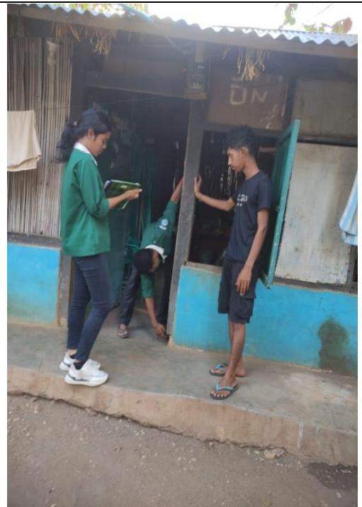
Survei kondisi dinding rumah
