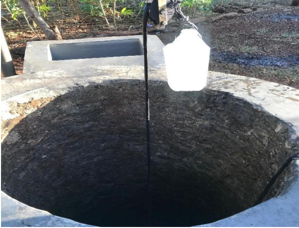
Gambar 1. Kondisi sumur gali.
