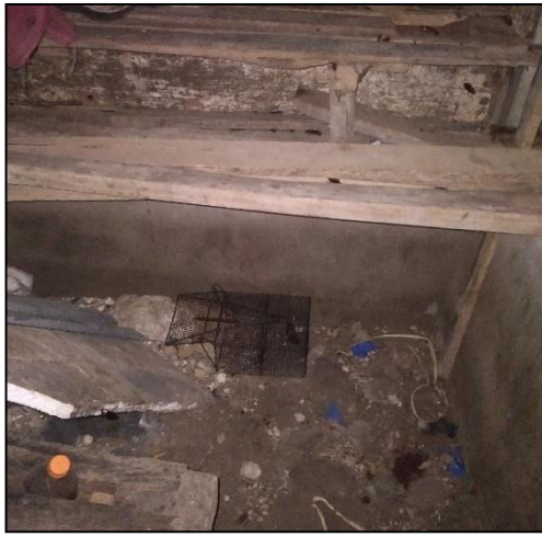
Pemasangan Perangkap di TPSS
