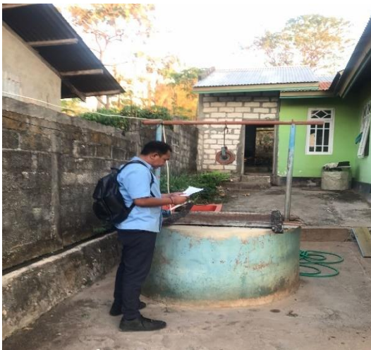
Inspeksi Sumur gali
