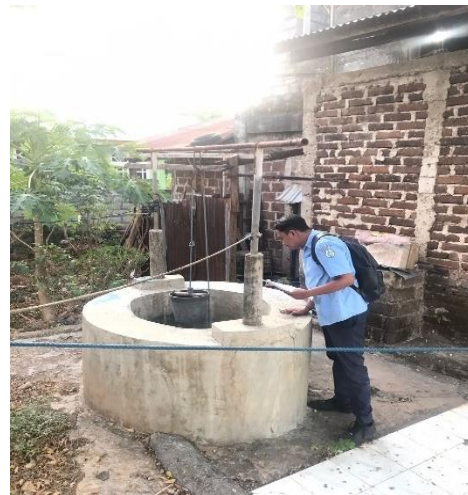
Inspeksi Sumur gali
