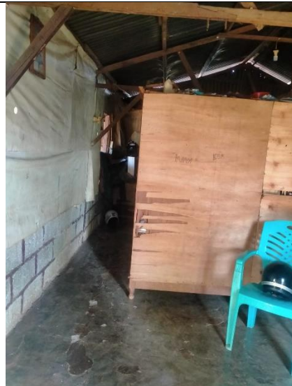
Gambar f. Jenis dinding dan jenis lantai
