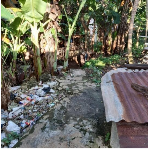
Kondisi sarana sumur bor 1
