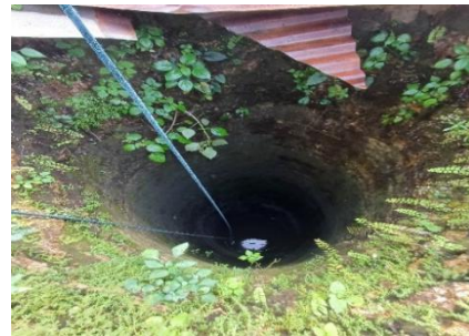
Tapak dalam bangunan sumur gali
