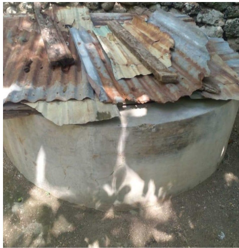
sarana air bersih sumur gali di kelurahan Tuak Daun Merah
