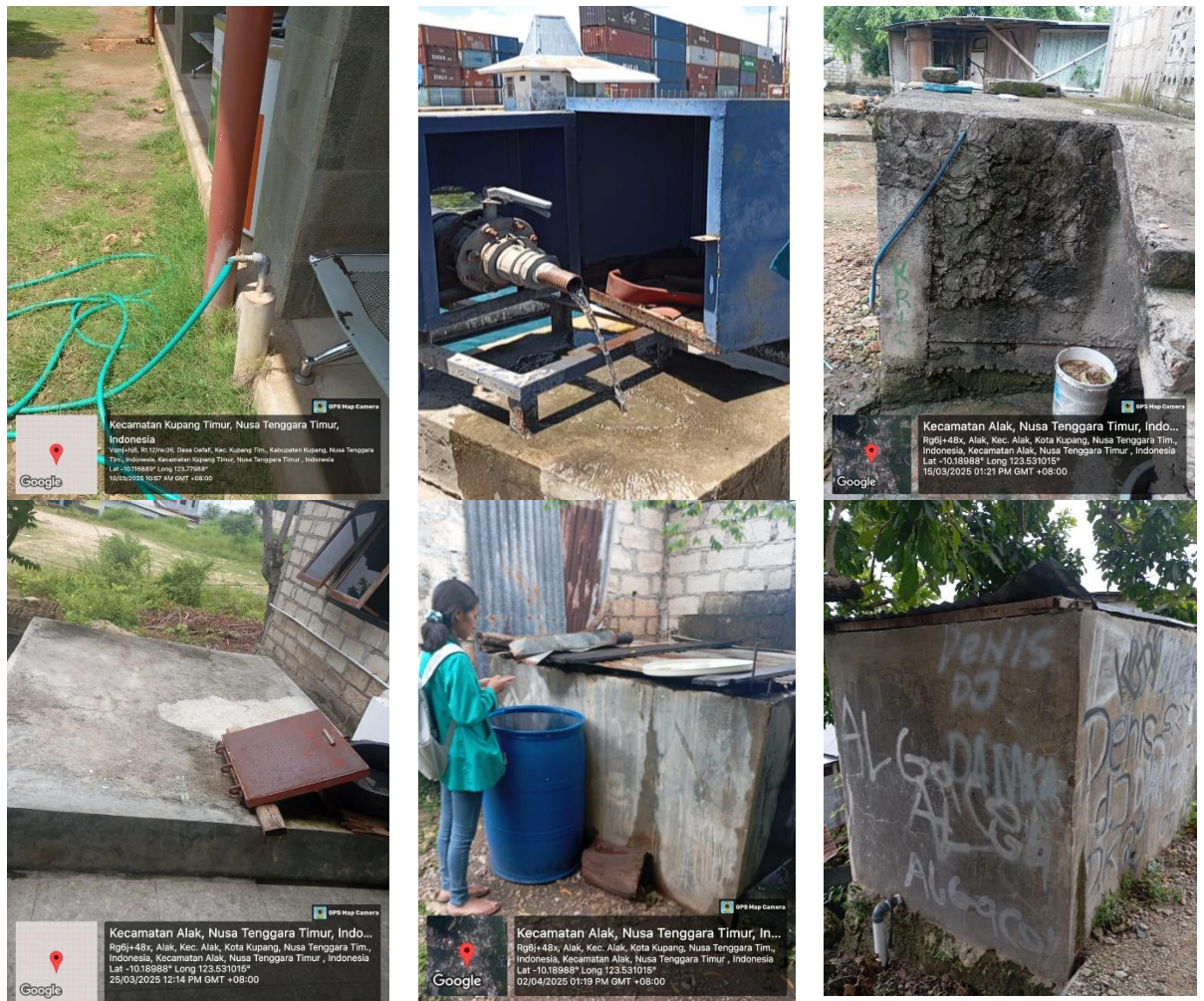
Dokumentasi kegiatan pemeriksaan jenis sarana air bersih pada daerah perimeter dan buffer di Pelabuhan Laut Tenau Kupang
