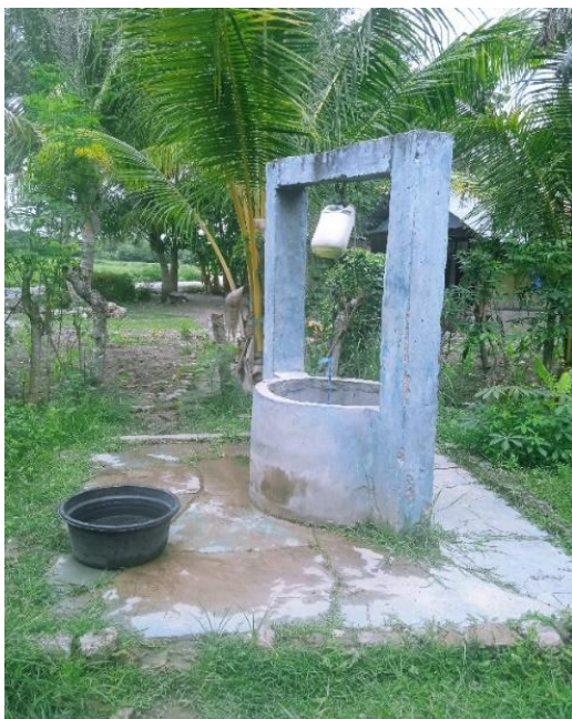
Sarana sanitasi penyediaan air bersih
