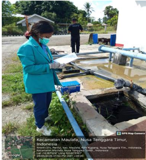
Survei Kondisi Bak Penampungan Air Bersih
