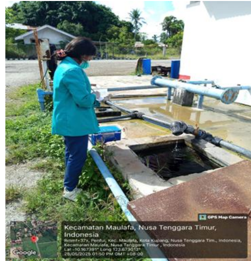
Survei Kondisi Bak Penampungan Air Bersih
