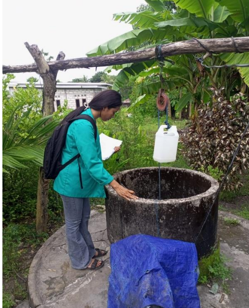
Melakukan inspeksi kondisi fisik sumur gali
