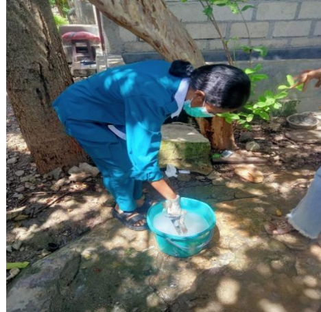
Menabur kaporit pada tabung kaporit dan mengaduk kaporit dalam ember
