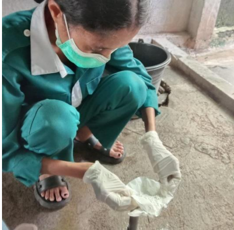
Menabur kaporit pada tabung kaporit dan mengaduk kaporit dalam ember
