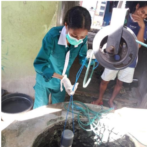
Menabur kaporit pada Sumur Gali dengan menggunakan tabung kaporit dan penuangan langsung
