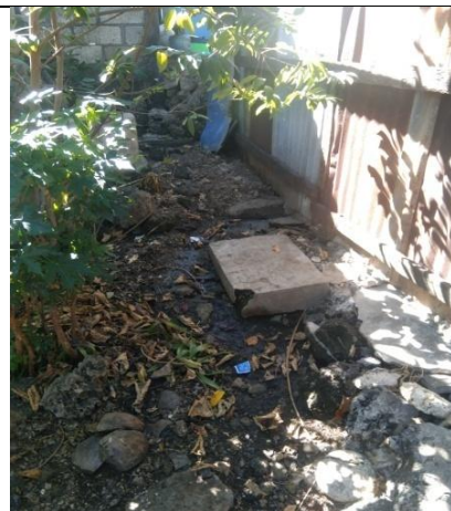
Survei saluran pembuangan limbah cair rumah tangga
