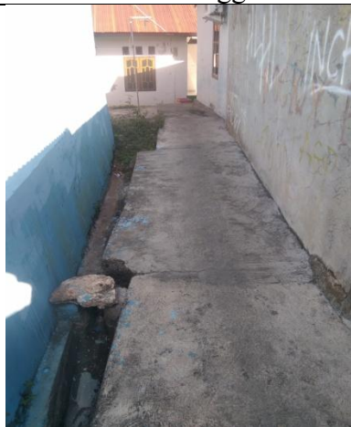
Survei saluran pembuangan limbah cair rumah tangga
