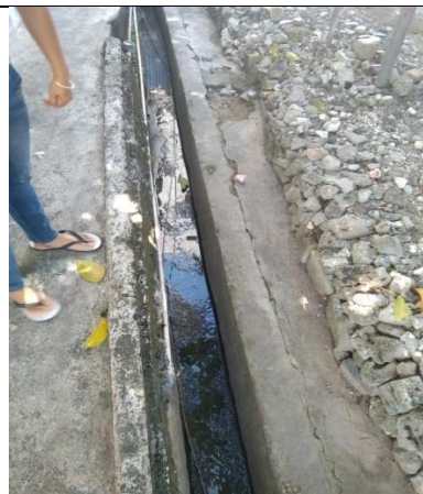
Survei saluran pembuangan limbah cair rumah tangga
