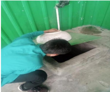
Inspeksi Bak penampung
