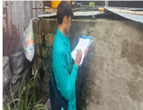
Inspeksi bak penampung
