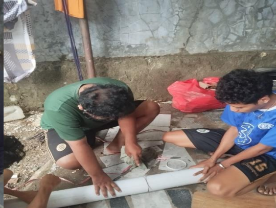
Proses pemotongan pipas sebagai tabung penyaring
