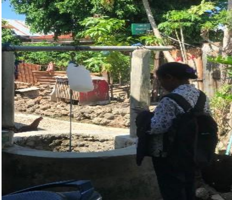
Inspeksi sumur gali menggunakan Epicolek
