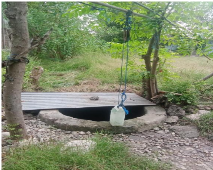
Kondisi dinding sumur dan ember timbah
