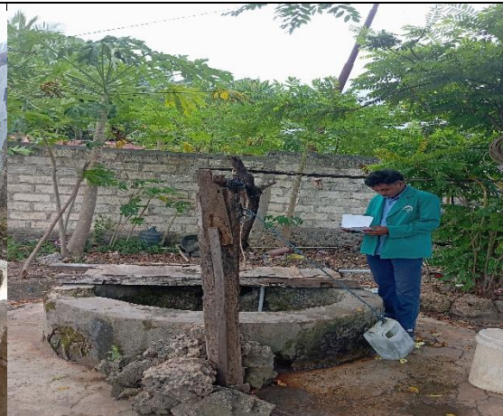
dokumentasi IKL Sumur Gali
