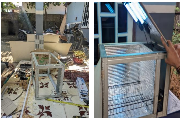
2. Pemasangan bagian-bagian alat dan perakitan kelistrikan dan lampu UV
