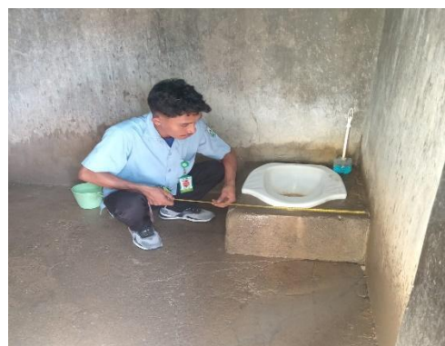
Pengukuran slab jamban
