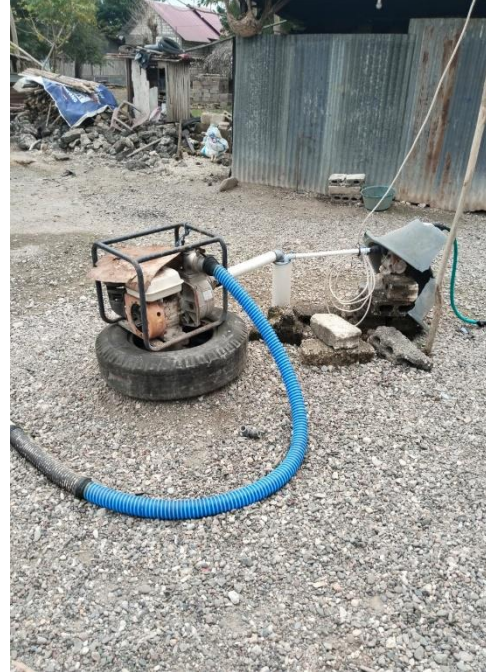
Dokumentasi ikl sumur bor
